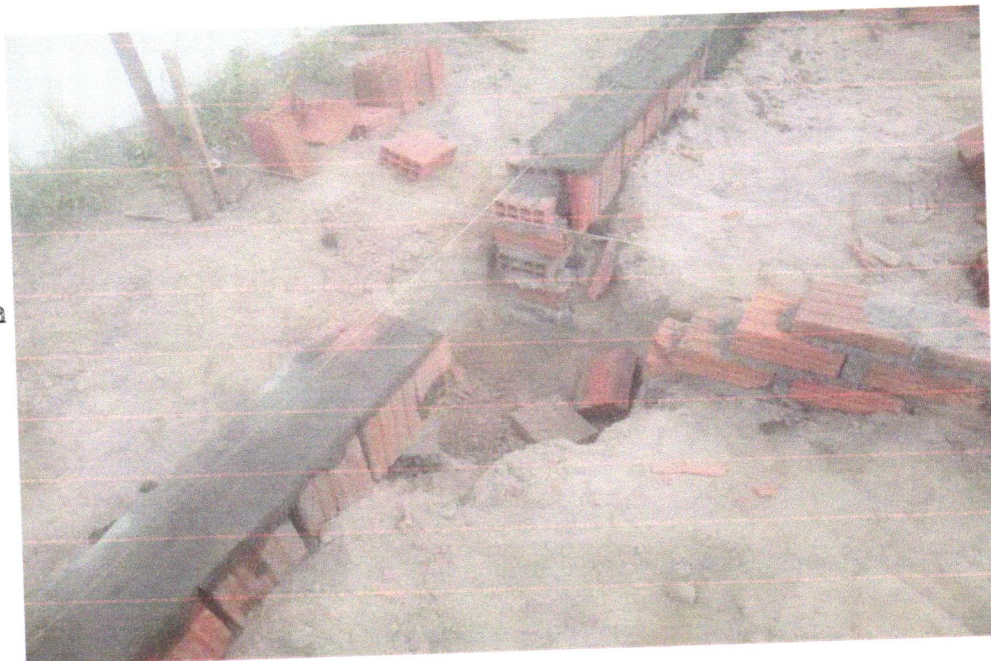
FOTO 04 - ESCAVAÇÃO MANUAL DE VALA PARA VIGA BALDRAME (INCLUINDO ESCAVAÇÃO PARA COLOCAÇÃO DE FÔRMAS). AF_06/2017
