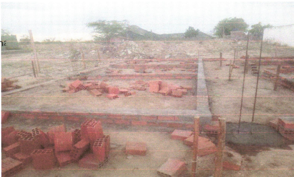
FOTO 8 - COMPOSIÇÃO REPRESENTATIVA) EXECUÇÃO DE ESTRUTURAS DE CONCRETO ARMADO, PARA EDIFICAÇÃO HABITACIONAL UNIFAMILIAR TÉRREA (CASA EM EMPREENDIMENTOS), FCK = 25 MPA. AF_01/2017
