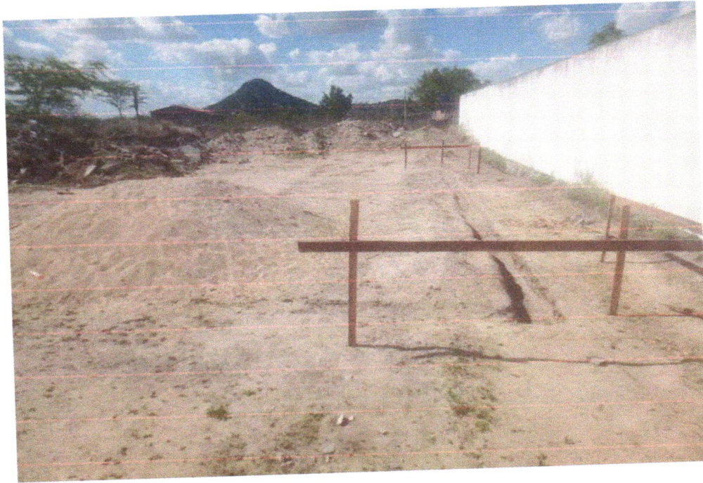
FOTO 03 - ESCAVAÇÃO MANUAL DE VALA PARA VIGA BALDRAME (INCLUINDO ESCAVAÇÃO PARA COLOCAÇÃO DE FÔRMAS). AF_06/2017
