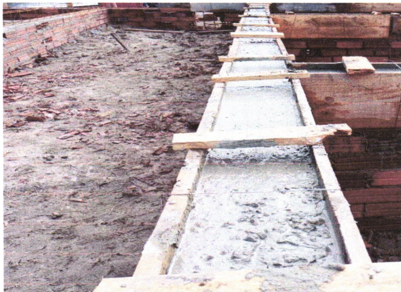
FOTO 9 – COMPOSIÇÃO REPRESENTATIVA) EXECUÇÃO DE ESTRUTURAS DE CONCRETO ARMADO, PARA EDIFICAÇÃO HABITACIONAL UNIFAMILIAR TÉRREA (CASA EM EMPREENDIMENTOS), FCK = 25 MPA. AF_01/2017
