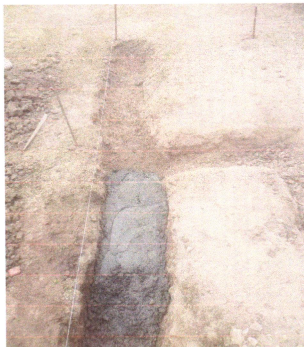
FOTO 06 - LASTRO DE CONCRETO MAGRO, APLICADO EM BLOCOS DE COROAMENTO OU SAPATAS, ESPESSURA DE 3 CM
