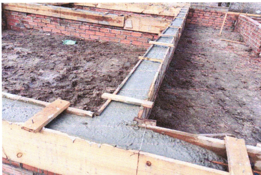
Foto 10- COMPOSIÇÃO REPRESENTATIVA) EXECUÇÃO DE ESTRUTURAS DE CONCRETO ARMADO, PARA EDIFICAÇÃO HABITACIONAL UNIFAMILIAR TÉRREA (CASA EM EMPREENDIMENTOS), FCK = 25 MPA. AF_01/2017
